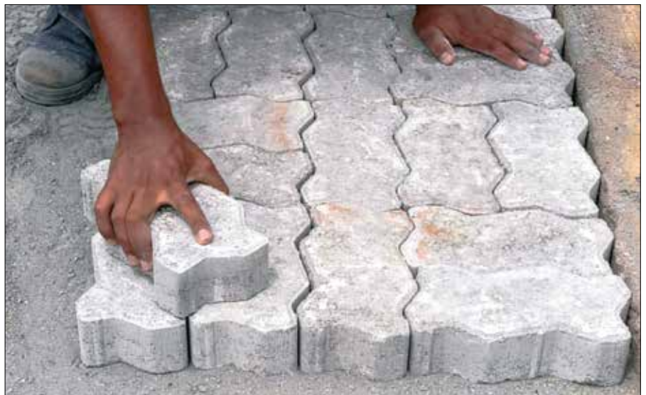
Assentamento de pisos intertravados de 16 faces
